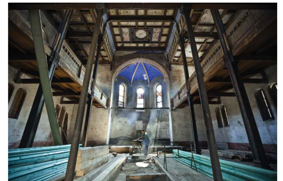
Synagóga Bytča, 2010, Bytča
